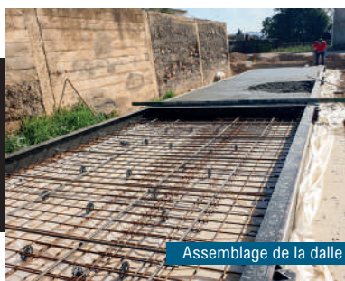
Construction de dalle sur sol
